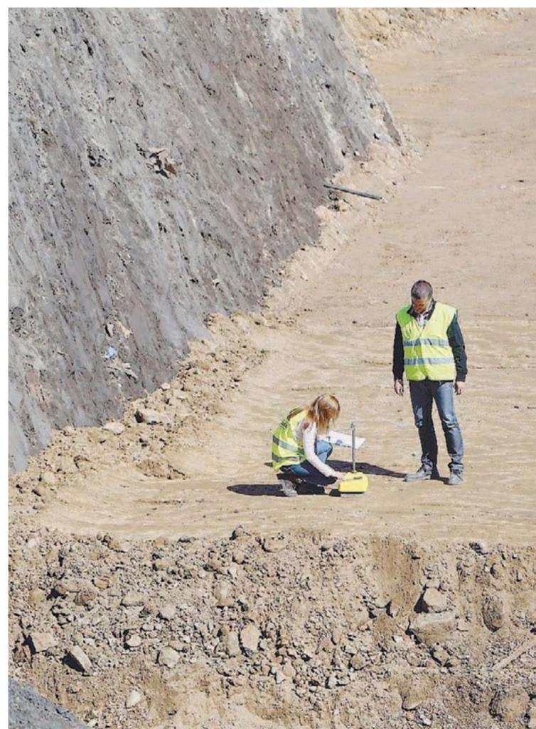
Solo limpo (mais claro), está a ser depositado, ficando em contacto com a “parede” de resíduos remanescentes, que tem cerca de 12 metros de altura
